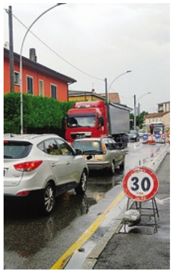
Il cantiere sulla provinciale 184
