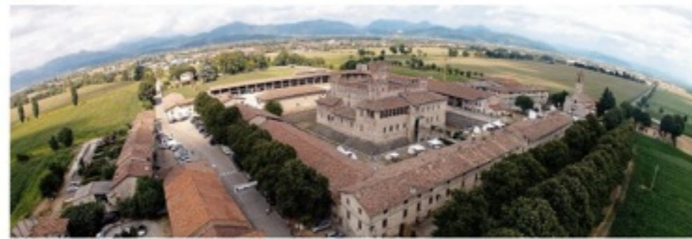
Foto aerea del Castello di Malpaga con il contesto ambientale circostante
